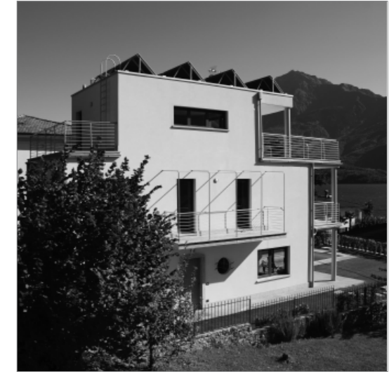
Casa di abitazione monofamiliare con piscina arch. Monica Cervini Vanoli Costruzioni – BI ELLE Costruzioni
