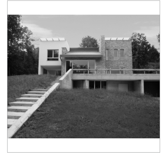
Casa Ponzoni ad Albavilla arch. Carlo Marelli e arch. Massimo Molteni Impresa Costruzioni Pontiggia s.a.s.
