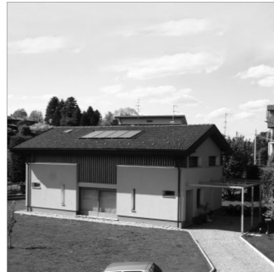
Casa ECO 2006 arch. Pietro Garbagnati Bortolato Costruzioni
