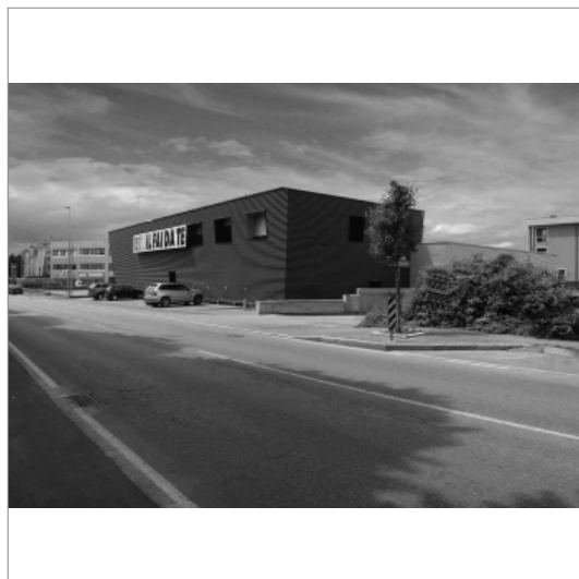
Ridisegni facciate Brico OK a Cantù arch. Carlo Marelli e arch. Massimo Molteni Vera S.r.l.
