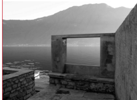
Ristrutturazione edificio residenziale a Sala Comacina arch. Nicola Mastalli Petazzi Costruzioni edili
