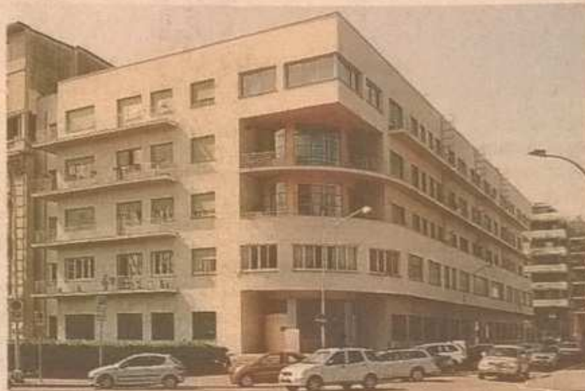
Il Novocomum di via Sinigaglia, sede dell'Ordine degli architetti
