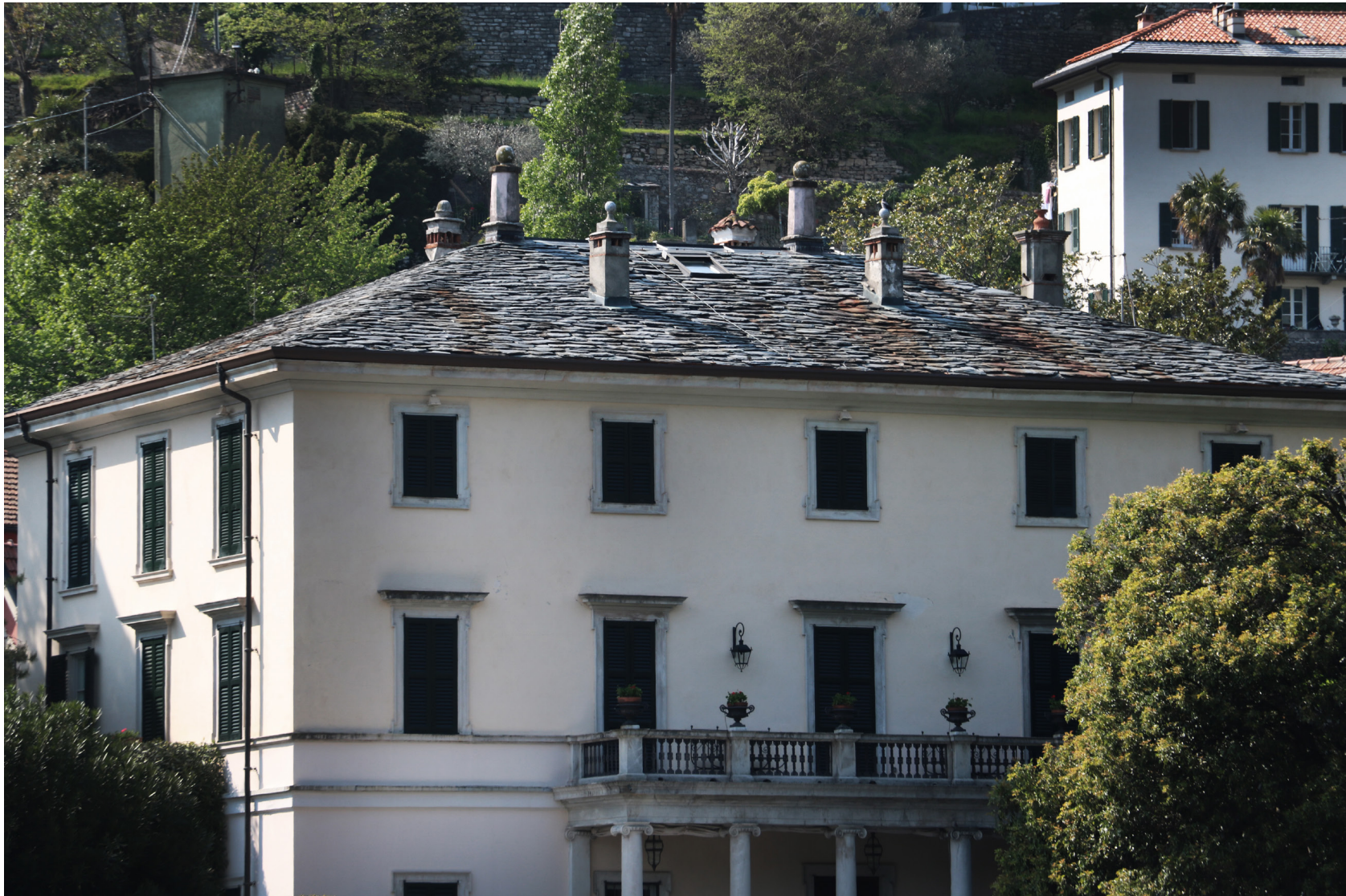
Tetto in scisti di Villa Oleandra
