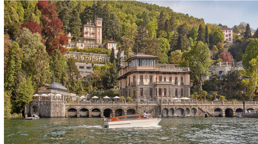
LA ROCCABRUNA - EX VILLA PASTA_BLEVIO Prevale il costruito sul parco
