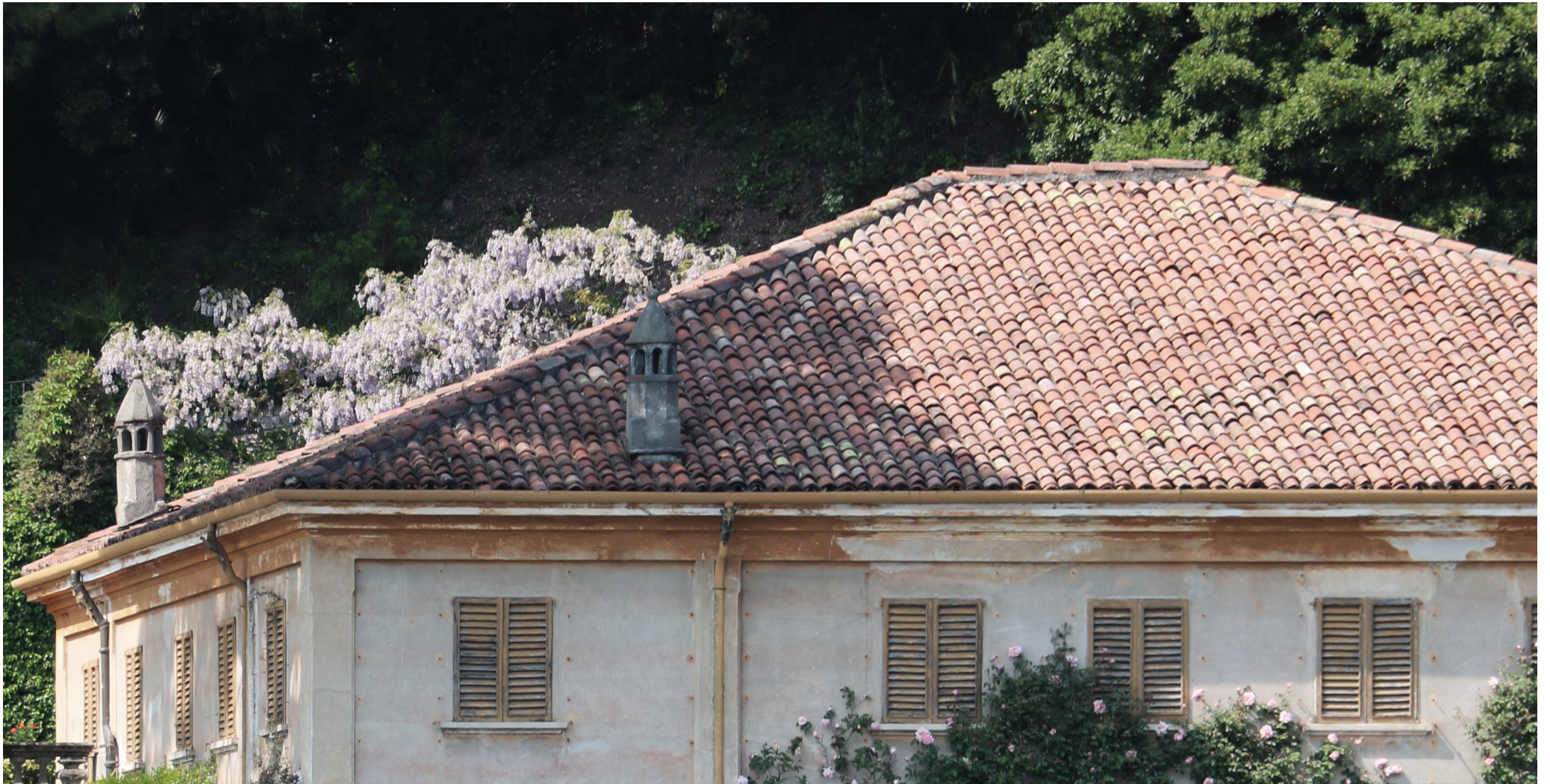
Manto di copertura in coppi a canale_Tetto tipicamente lombardo
