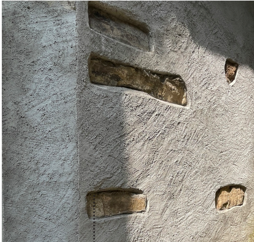
⋮ ESEMPIO DI STONACATURA PARZIALE
