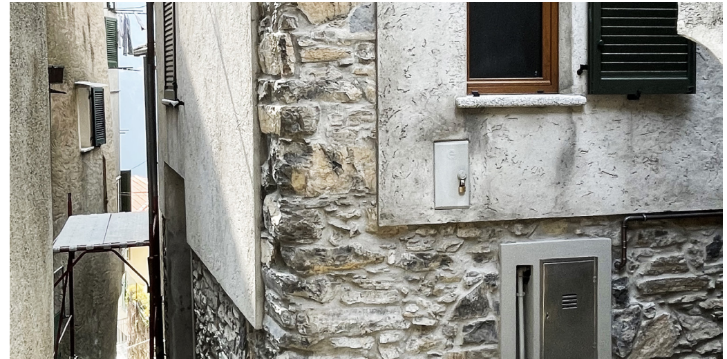
ESEMPIO DI STONACATURA DEL CANTONALE
