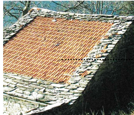
SOSTITUZIONE DELLE PIDE CON TEGOLE MARSIGLIESI A ERBONNE
