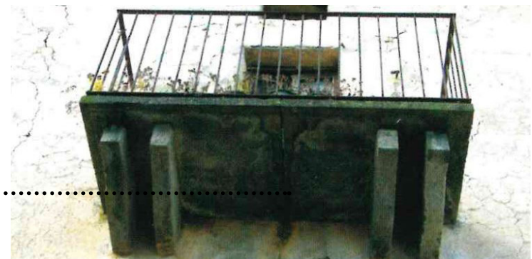
LASTRA SPACCATA DI UN BALCONE A CASASCO
