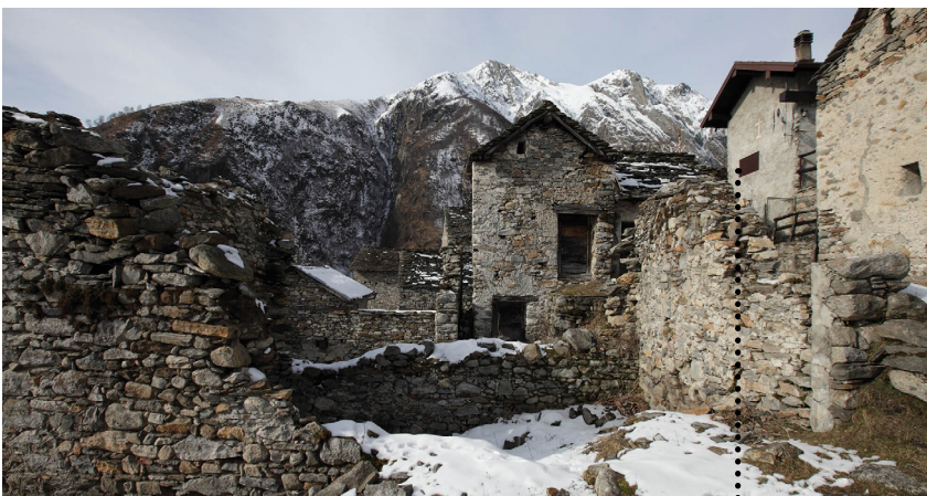
APERTURE POCO FREQUENTI E DI DIMENSIONI RIDOTTE PER EDIFICI RURALI D'ALTURA
