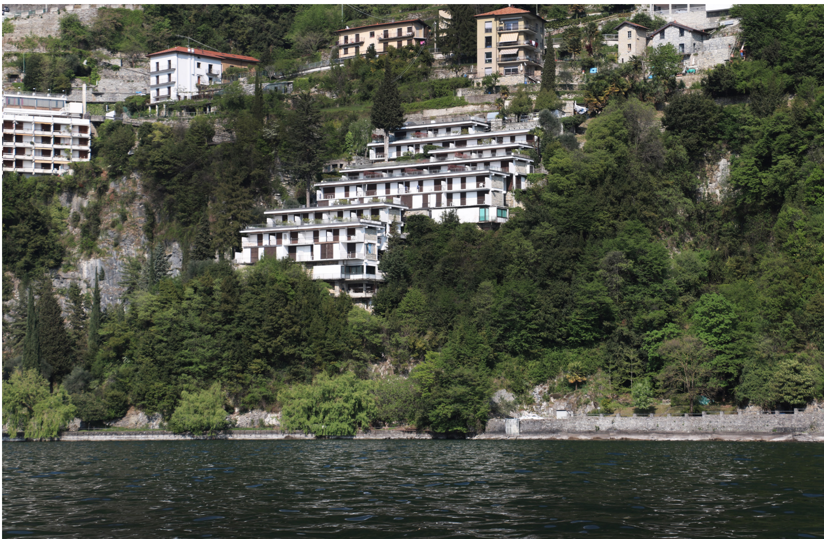
Esempio di edilizia terrazzata a Pognana Lario
