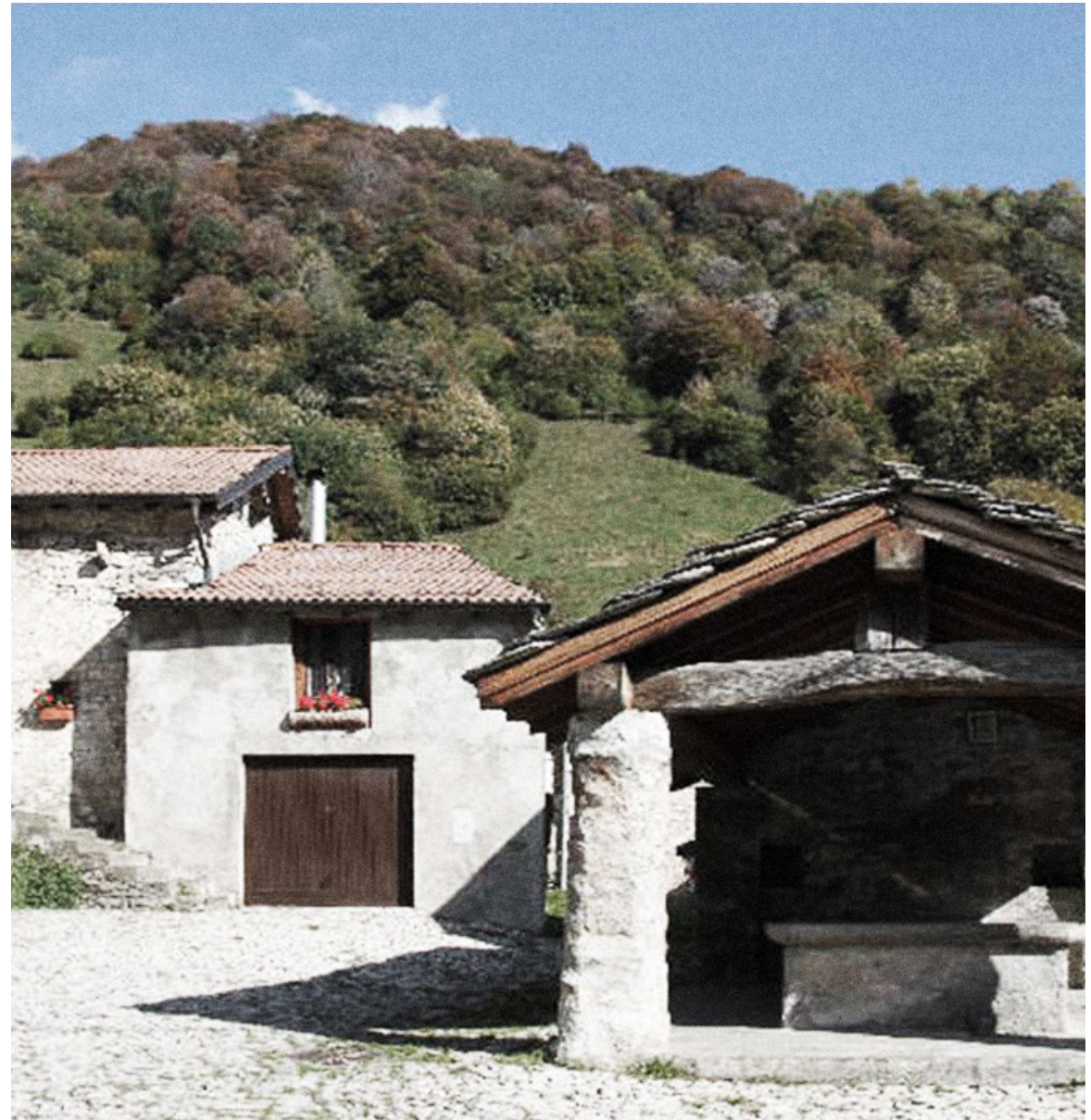
Lavatoio di Erbonne
