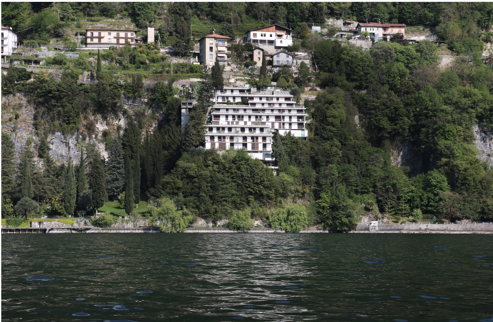
Esempio di edilizia terrazzata a Pognana Lario
