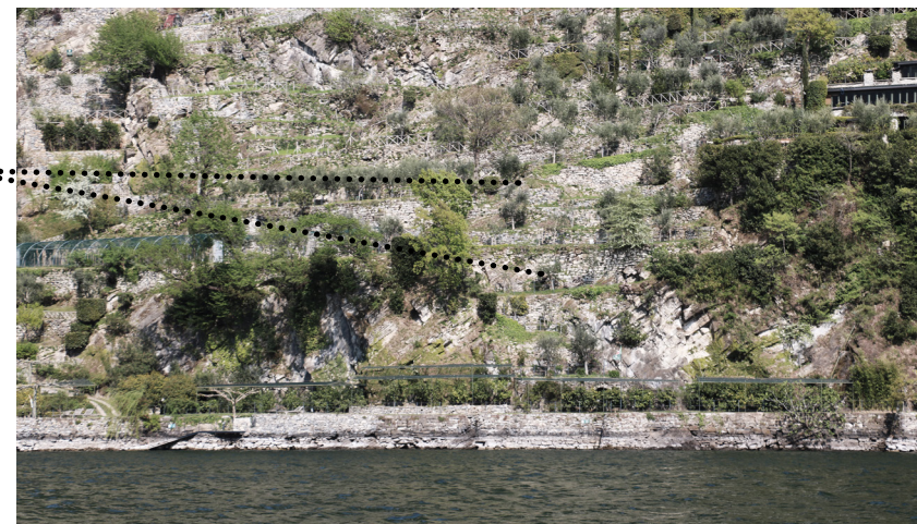
AZIENDA AGRICOLA I ROSPI_CARENO (NESSO) L'intervento ha riportato alla luce i terrazzamenti prima completamente coperti di vegetazione boschiva
